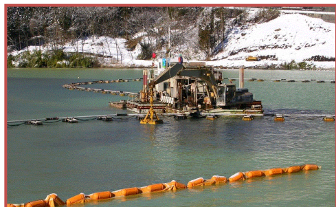
ダムの浚渫(群馬県)
